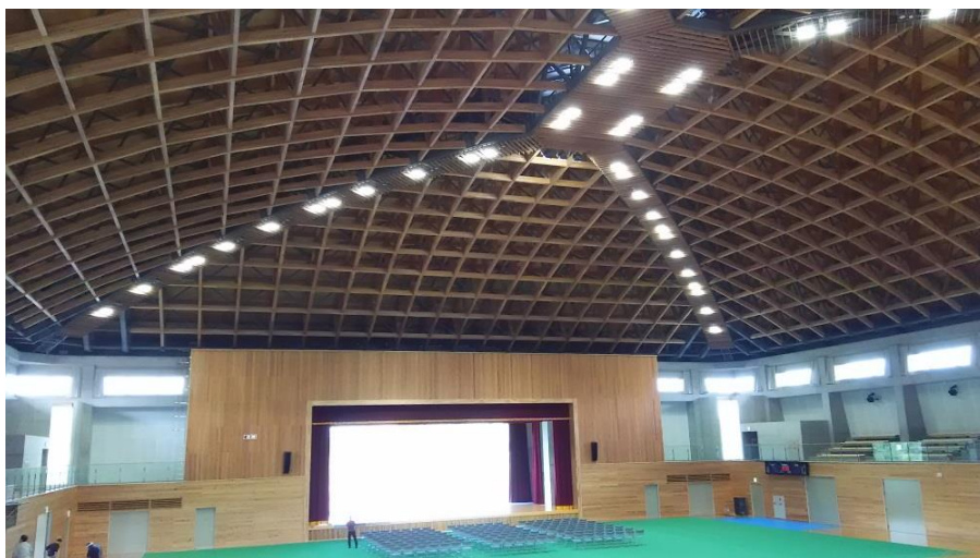
構造用木材を使用した体育館（奈良県五條市）
