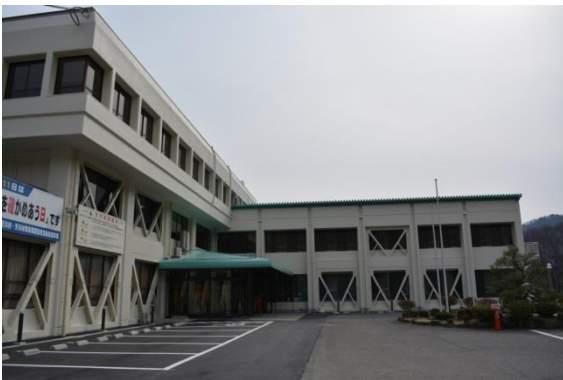
【市町村庁舎の耐震改修】
