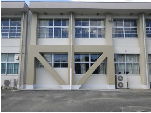
【特別支援学校の耐震改修】
