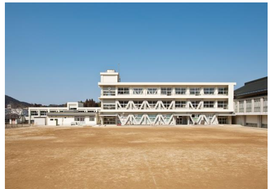
【中学校の耐震改修】
