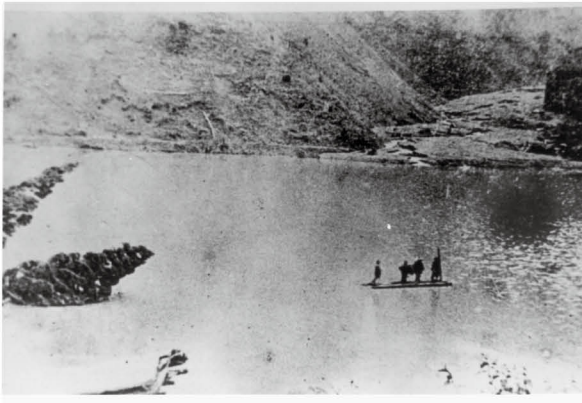
大水害により、川がせき止められ湖が出現 (明治22年 奈良県北十津川村)
