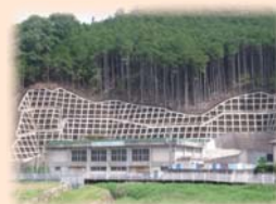
急傾斜地崩壊対策事業(宇陀市菟田野下芳野)
