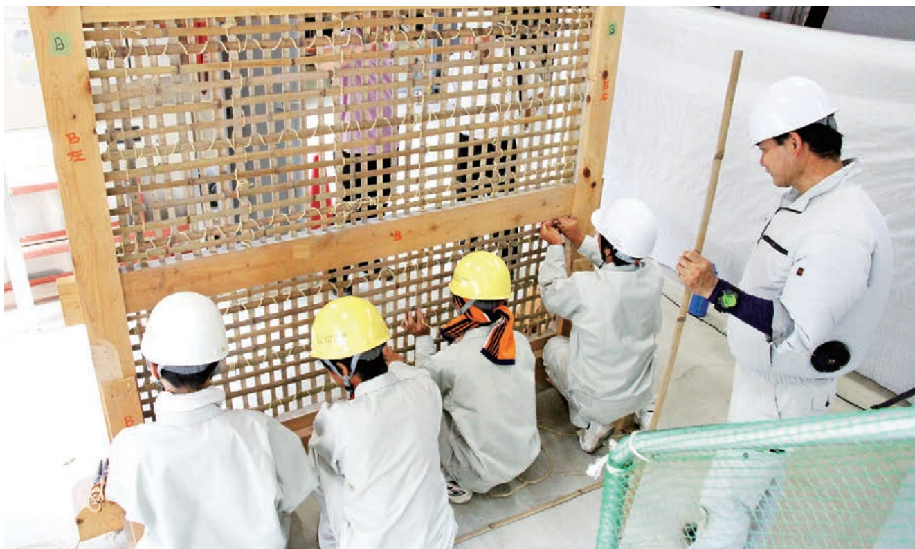
「未来の“匠”養成」文化財建造物修復現場インターンシップ(県文化財保存事務所称念寺出張所)
