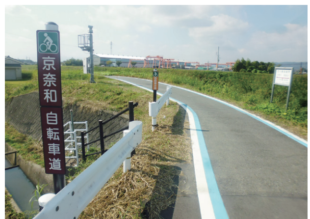
京奈和自転車道の整備(大和郡山市)
