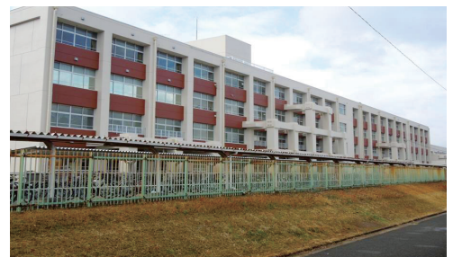
耐震化の完了した校舎
