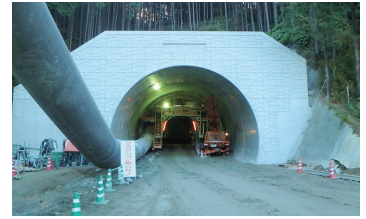
(国)169号 高取BP (仮称)清水谷トンネル(高取町)
