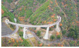
橋梁点検の実施 (国道169号伯母谷ループ橋)(川上村)
