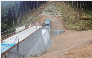
砂防対策工事の推進 (山田沢)(天理市)
