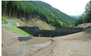
治山事業の推進 (川上村高原地区)
