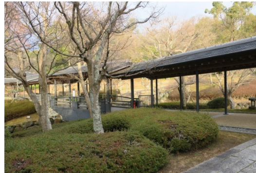
写真:別館連絡道の外観 本館北側から撮影
