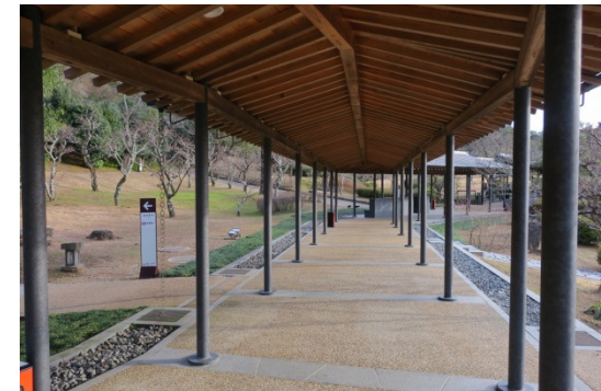
写真:別館連絡道 北側入口付近から撮影
