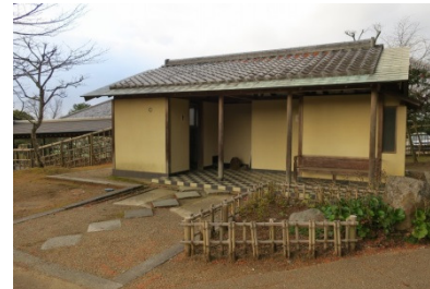
写真: トイレ棟附近
