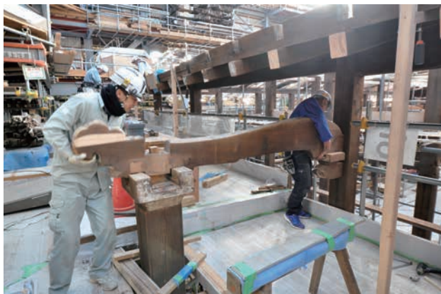
木部組立て（古材を修繕し再使用）
