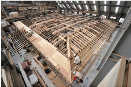
軒廻り施工中
