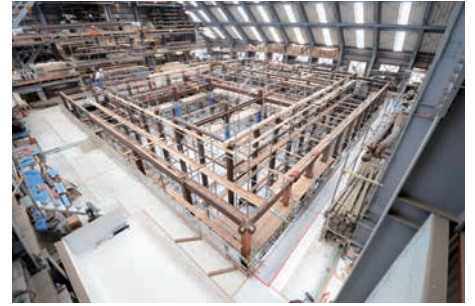
軸部組立完了
