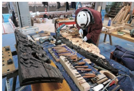
古材修理 (妻飾り) 【本堂の組み立て状況】
