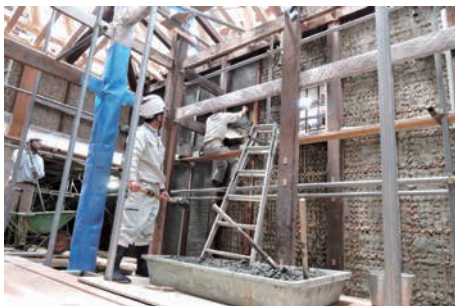
内部壁土塗り
