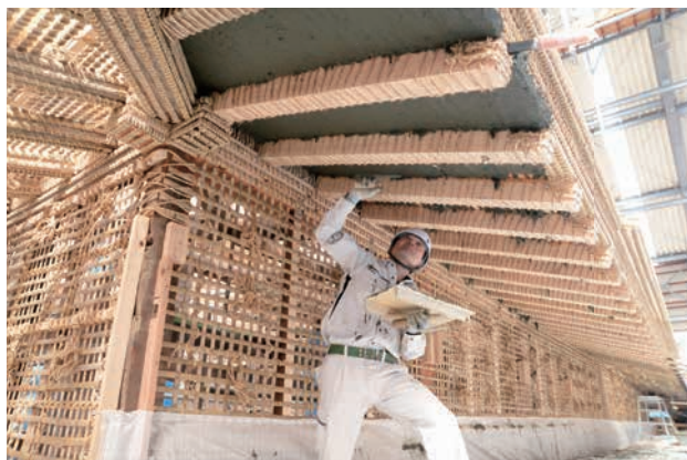
左官工事（壁土塗り）
