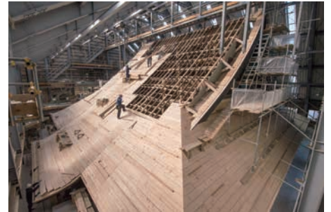
野地板施工中
