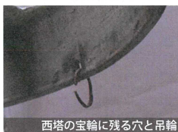
西塔の宝輪に残る穴と吊輪
