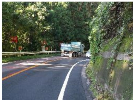
写真1 急カーブでのすれ違い (正面衝突が発生しやすい状況)
