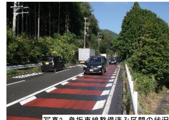
写真2 登坂車線整備済み区間の状況
