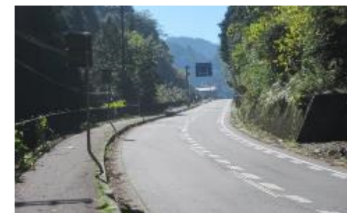
写真3 2車線整備済み区間の状況
