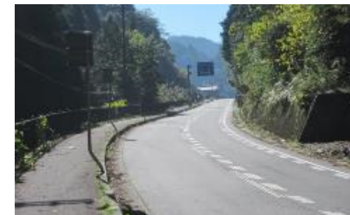
写真3 2車線整備済み区間の状況
