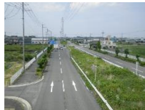
写真2 4車線整備済み区間の状況 (大和中央道)
