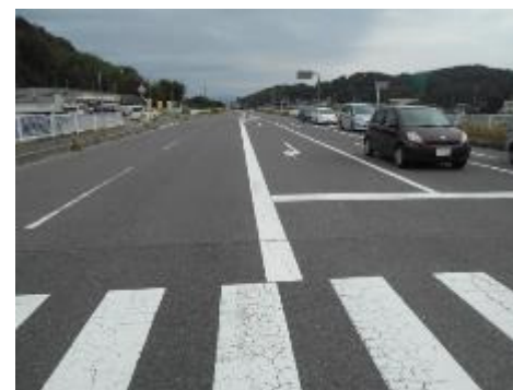
写真1 4車線整備済み区間の状況 (中町工区北隣の藤ノ木工区)
