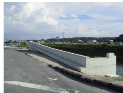
写真1 富雄川左岸側の橋台完了状況
