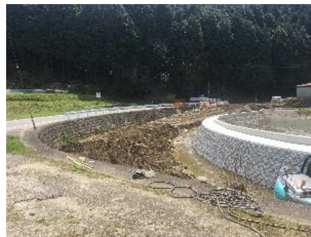
写真1 工事中区間の状況
