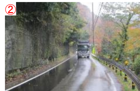
写真1・2 阪本工区現道の状況(1車線)
