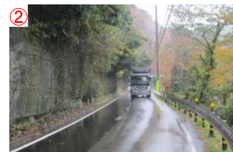
写真1・2 阪本工区現道の状況(1車線)
