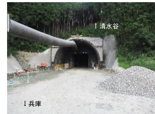
写真2 工事中区間の状況(2工区)
