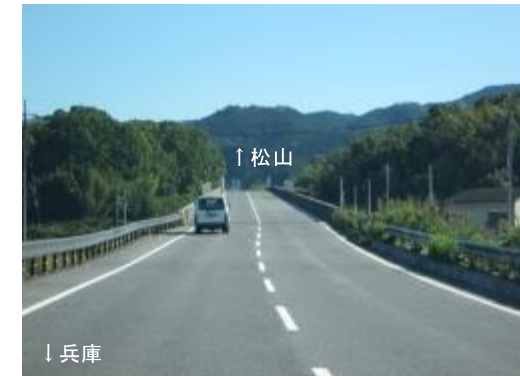
写真1 供用済み区間(1工区)
