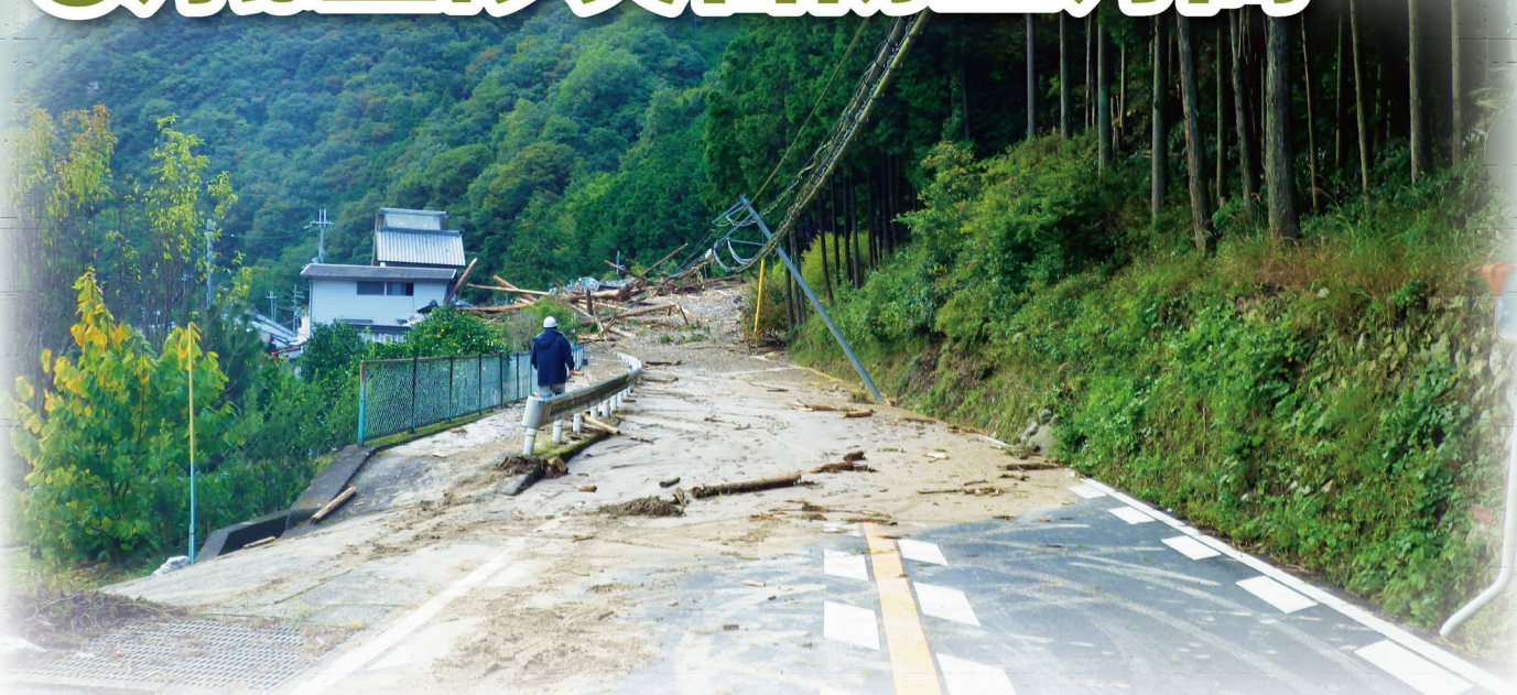
平成29年の台風21号による 被害の様子
