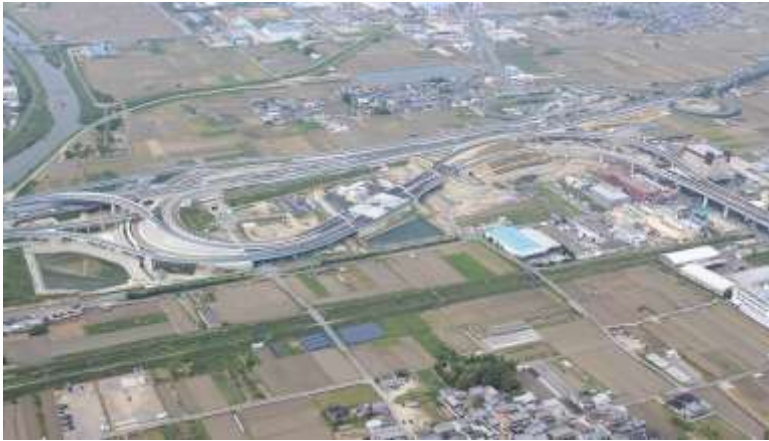
H27年3月に供用開始した郡山下ッ道JCT
