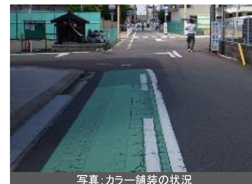
写真: カラー舗装の状況
