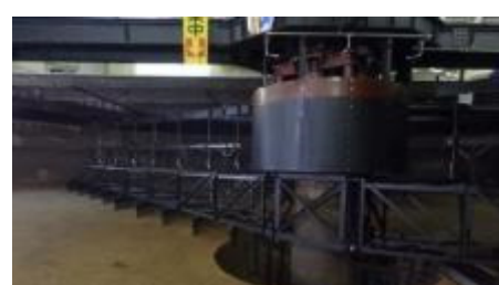
老朽化した施設の更新(上: 汚泥脱水機、下: 汚泥掻寄機)
