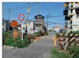
▲南大安寺踏切道
