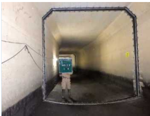
処理場の耐震化工事 (可とう継手の設置)
