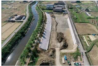
▲【工事中】流域貯留施設(王寺町)
