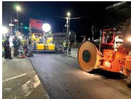
舗装補修工事
