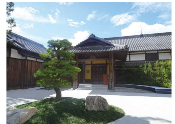
▲旧知事公舎エントランス
