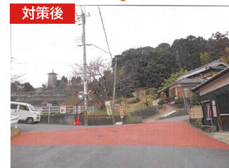
▲交差点のカラー舗装化(県道山稜王寺線 王寺町本町)
