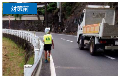
▲通学通園路の合同点検で対策が必要となった箇所 (国道369号 宇陀市榛原檜牧)
