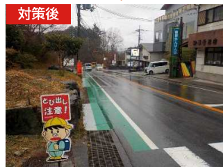
▲路側帯のカラー舗装化(国道309号 大淀町下瀬)
