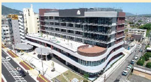
大和高田市 シビックコア周辺地区 (市庁舎/R3年4月完成)
