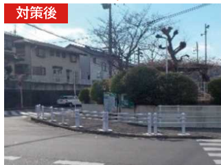
▲防護柵設置(県道畠田藤井線王寺町本町)
