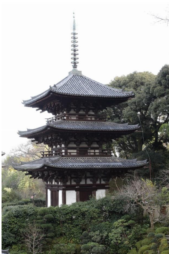
国宝当麻寺西塔 修理前全景(北西より撮影)
