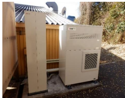
飲食店へのガスコージェネレーションシステムの導入
