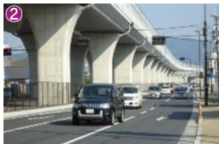
側道部(大阪行き) 片側2車線
