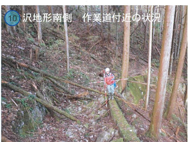
11 沢地形南側 作業道付近の状況 径20cm~30cm程度の落石が多数確認された。
