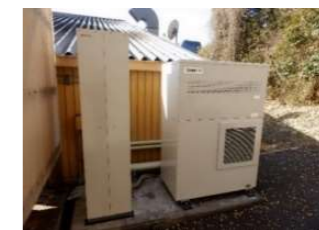
飲食店へのガスコージェネレーションシステムの導入
