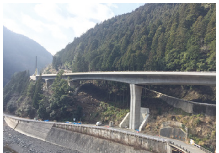
平成30年3月に開通した一般国道168号辻堂バイパス(五條市)
