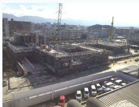
工事状況(平成30年11月下旬)
