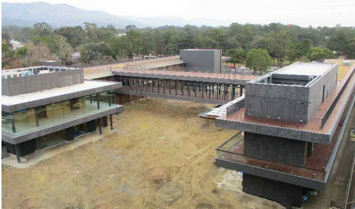
工事状況(平成30年12月)
