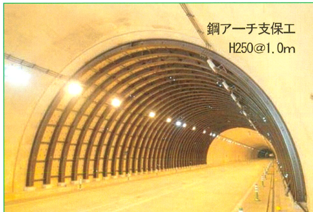
論文「国道168号(土河屋トンネル)の覆工変状に対する安全対策について」より抜粋
