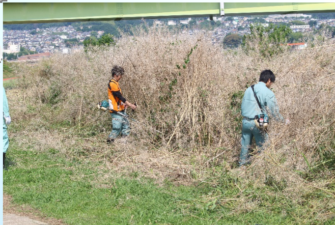
大和川低水護岸の草刈り
