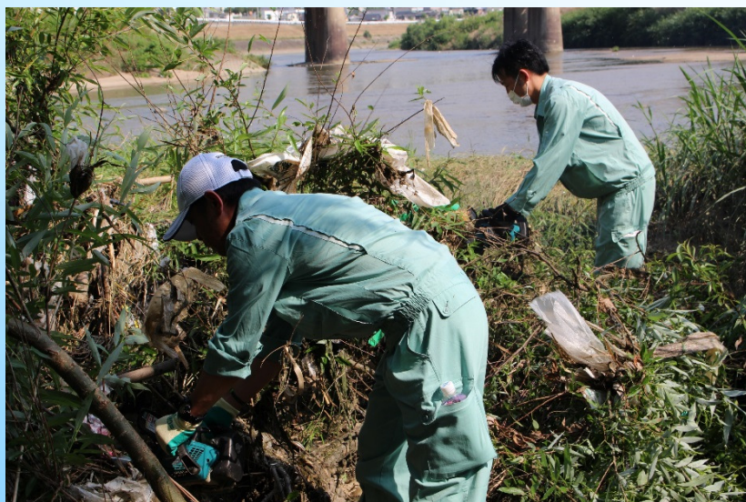
大和川低水護岸の雑木伐採
