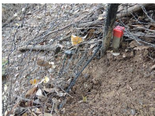
図4 動物の侵入によるネット下部の浮き
