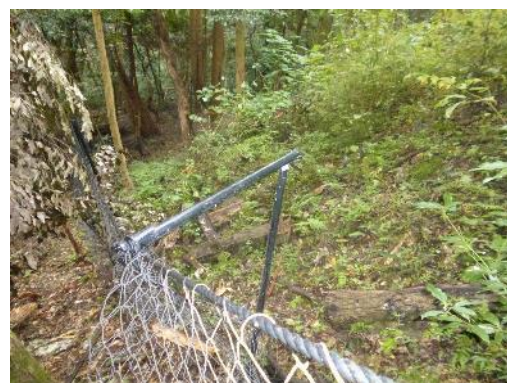
図3 倒木による植生保護柵の破損
