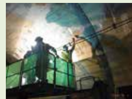
▲ トンネルの点検状況
