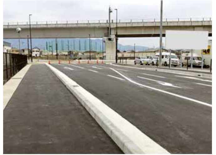
② (主) 榎原高取線 一町工区 [平成31年3月一部開通]
