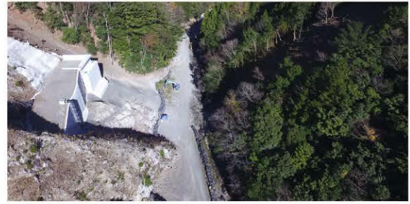
▲工事のようす
