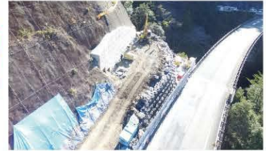
▲工事のようす
