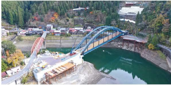
▲工事のようす
