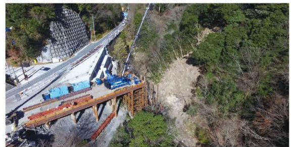
▲工事のようす
