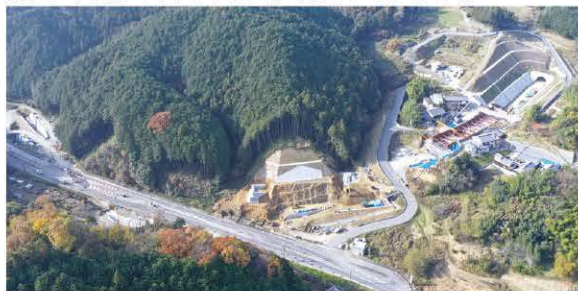
▲工事のようす
