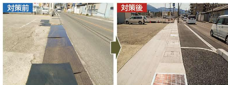
▲歩道設置（国道166号 葛城市尺土）
