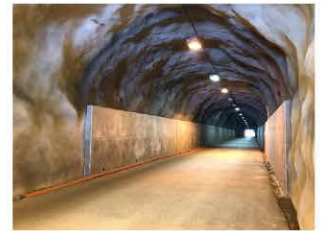
▲モルタル吹付工などによる補修 (国道169号 大里トンネル)
