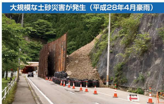
▲法面対策による通行機能の確保（国道168号 五條市大塔町小代）
