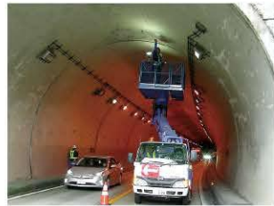
▲トンネル定期点検の状況
