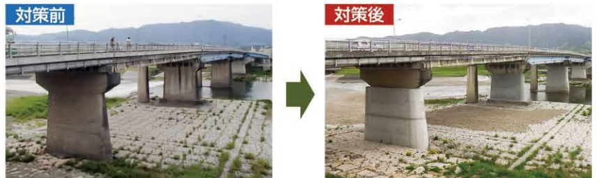
▲橋脚巻立て工による耐震補強工事（国道168号 大川橋）
