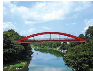
▲塗装塗替工などによる補修 (県道平原五條線 栄山寺橋)
