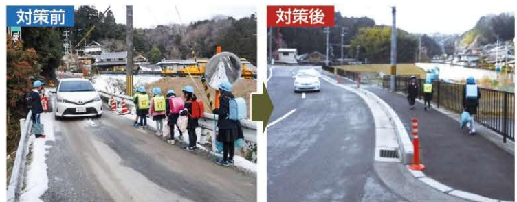
▲歩道設置（県道月瀬三ヶ谷線 山添村大塩）
