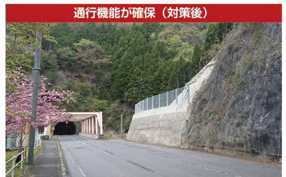
▲法面対策による通行機能の確保（国道168号 五條市大塔町小代）
