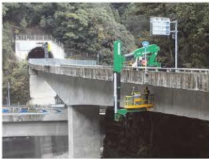
▲橋梁定期点検の状況
