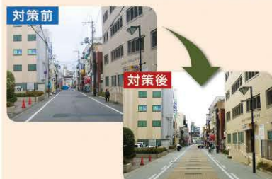
▲無電柱化(県道大和八木停車場線)
