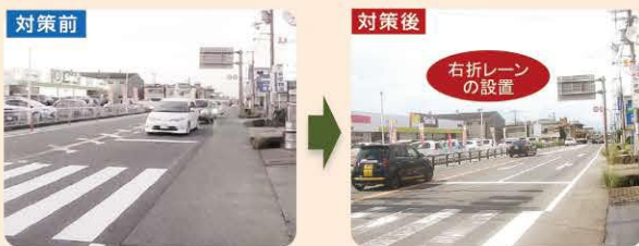
▲渋滞緩和に向けた速効対策 (県道桜井明日香吉野線 安部木材団地5号交差点 (R1.12実施))
