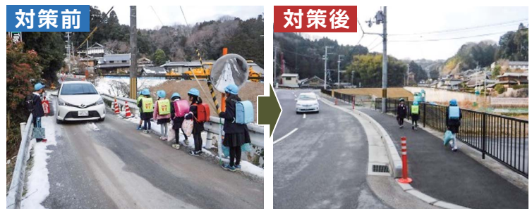
▲歩道設置（県道月瀬三ヶ谷線）
