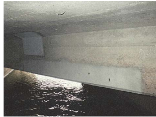
▲補修完了後(断面修復工)
