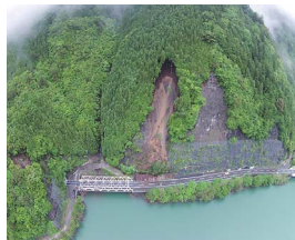
▲国道168号被災状況
