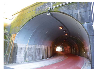
▲鋼板接着工などによる補修(国道169号 音枝トンネル)
