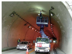
▲トンネル定期点検の状況
