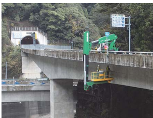
▲橋梁定期点検の状況
