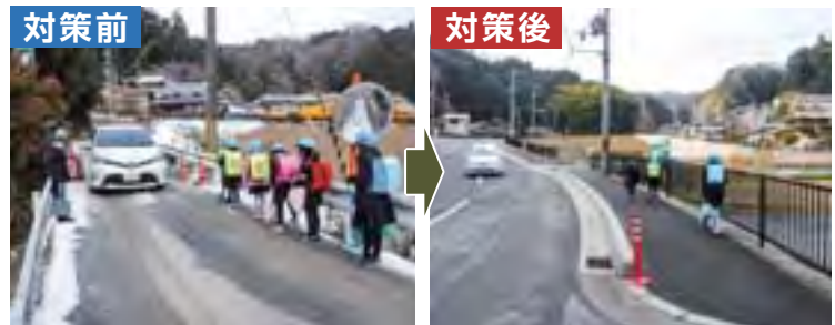
▲歩道設置（県道月瀬三ヶ谷線）
