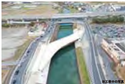
※工事中の写真
