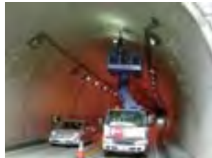
▲トンネル定期点検の状況
