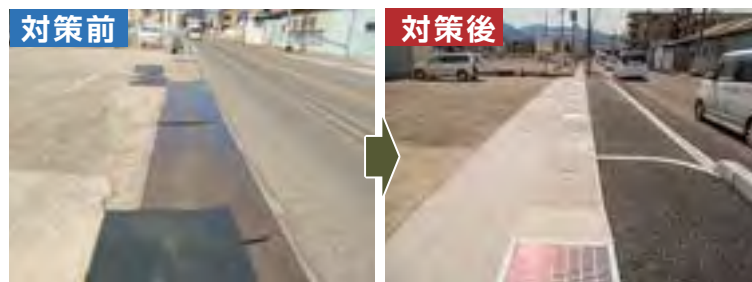
▲歩道設置（国道166号）
