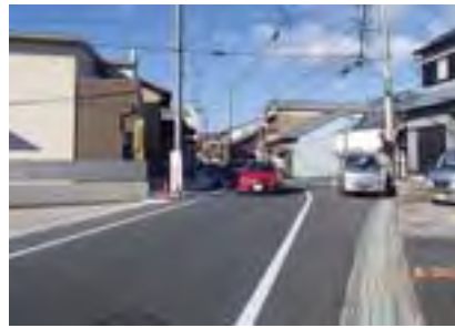
② (一)赤滝五條線 野原工区 (5工区) [令和元年11月全線開通]
