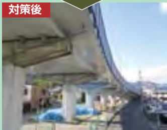
▲橋梁の補修工事 （県道天理王寺線王寺跨線橋）
