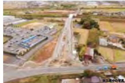
※工事中の写真
