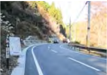
⑦ (主)吉野東吉野線 小川～鷲家工区 [令和元年12月一部開通]
