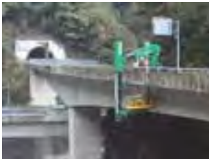
▲橋梁定期点検の状況
