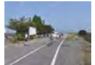
▲京都府域（延長：約45km） 京都八幡木津自転車道線
