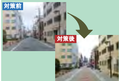
▲無電柱化（県道大和八木停車場線）
