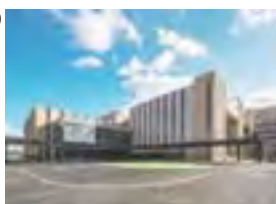
▲奈良県総合医療センター
