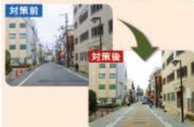
▲無電柱化 (県道大和八木停車場線)
