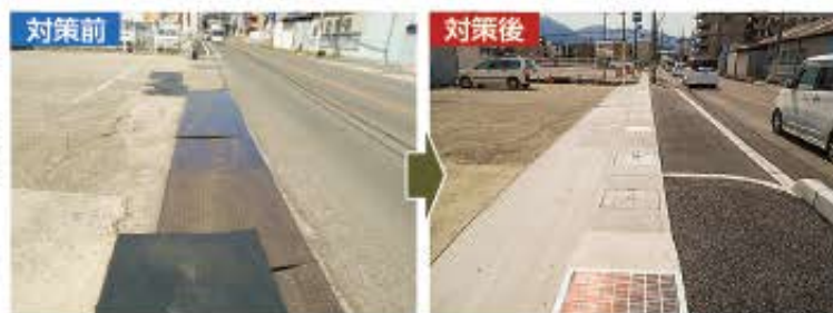
▲歩道設置（国道166号 葛城市尺土）
