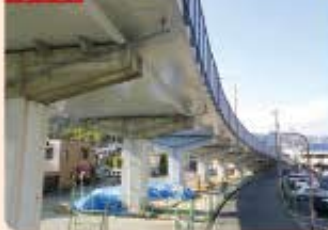
▲橋梁の補修工事 (県道天理王寺線王寺跨線橋)
