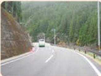
▲役場へのアクセス道路の整備 (県道高野天川線 庵住工区(R2.11供用))
