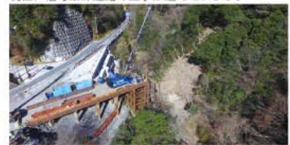
▲工事のようす
