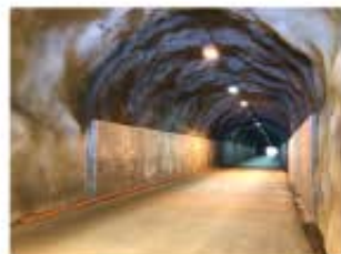
▲モルタル吹付工などによる補修 (国道169号 大里トンネル)
