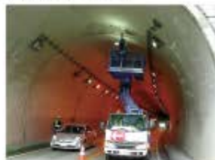
▲トンネル定期点検の状況
