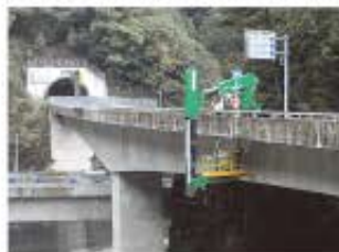
▲橋梁定期点検の状況
