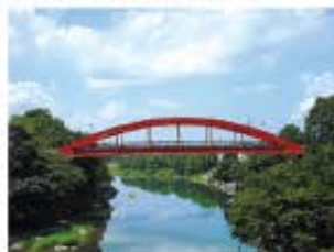
▲塗装塗替工などによる補修 (県道平原五條線 栄山寺橋)
