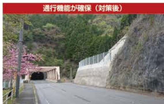
▲法面对策による通行機能の確保（国道168号 五條市大塔町小代）
