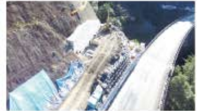
▲工事のようす
