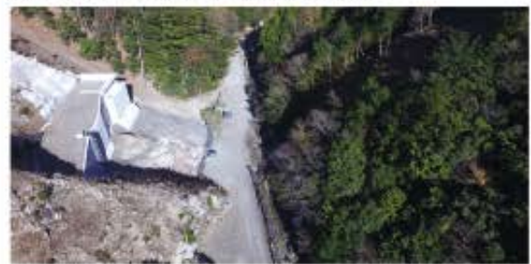
▲工事のようす
