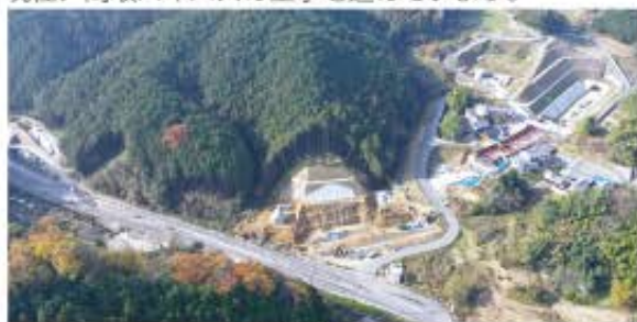
▲工事のようす
