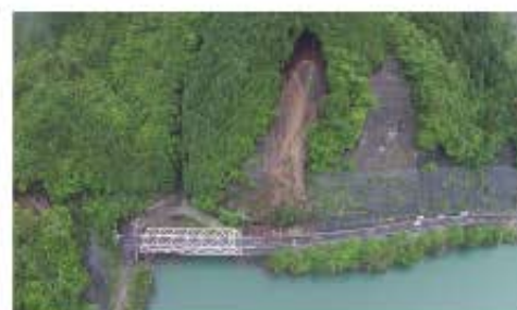
▲国道168号（五條市大塔町小代）被災状況
