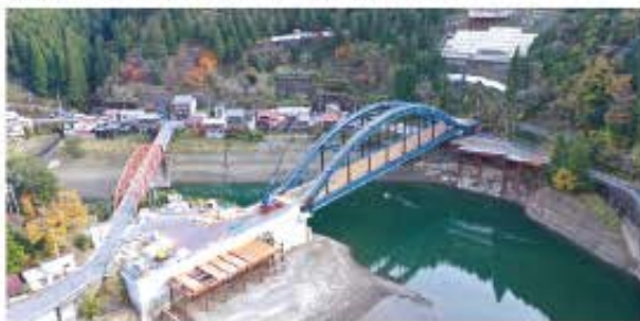
▲工事のようす
