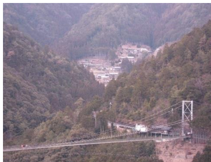
◆谷瀬の吊り橋
