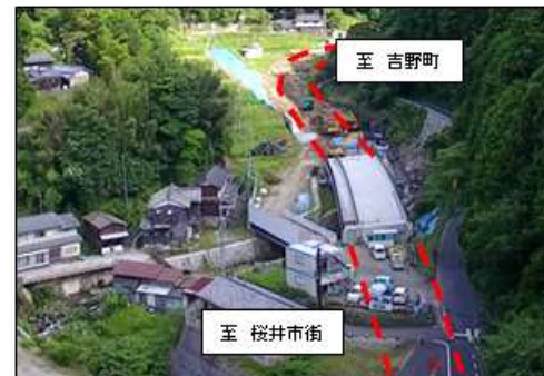
2車線改良工事を推進(桜井市百市)
