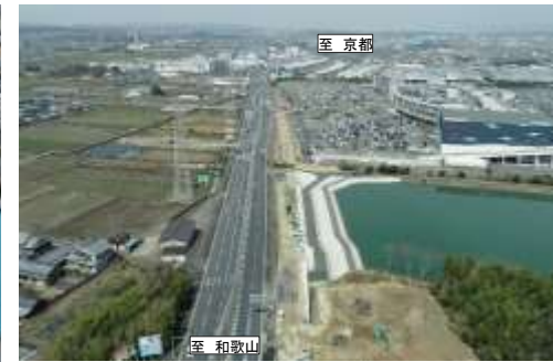
道路拡幅工事(大和郡山市下三橋町)
