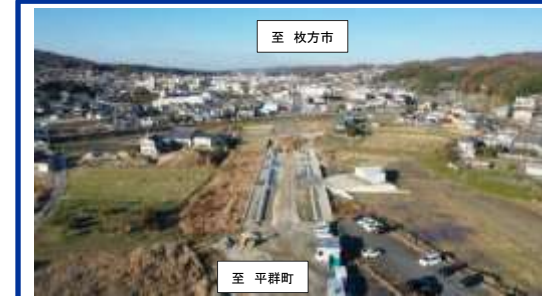
4車線のバイパス工事を推進(生駒市小瀬町)
