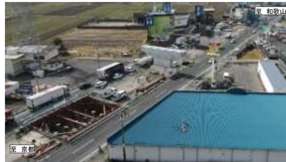
橋梁下部工事等を推進(大和郡山市横田町)
