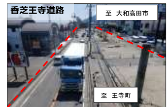
4車線拡幅工事を推進(香芝市上中)
