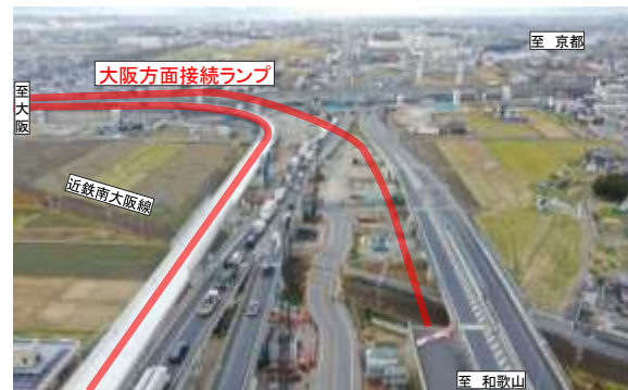
大阪方面接続ランプ工事を推進(橿原市新堂町)
