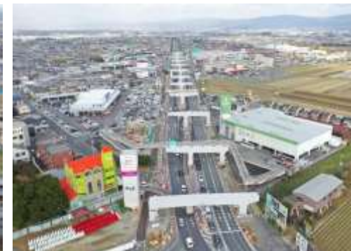
橋梁下部工事(橿原市曲川町)
