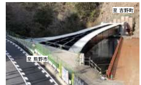
橋梁工事を推進(上北山村西原)
