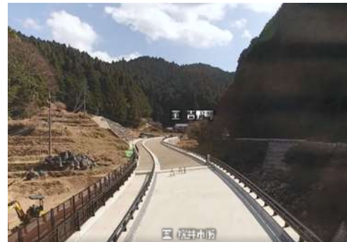
2車線改良工事を推進(桜井市百市)
