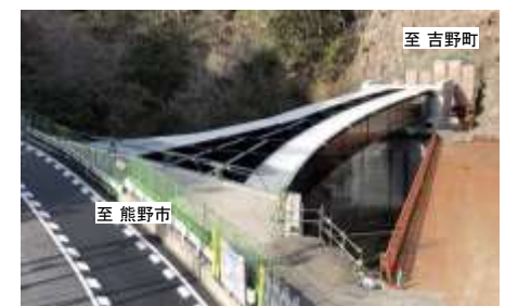
橋梁工事を推進(上北山村西原)
