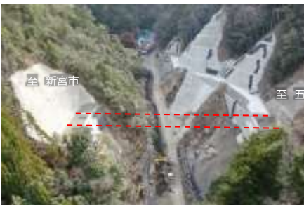
橋梁上下部工事を推進(十津川村 長殿)
