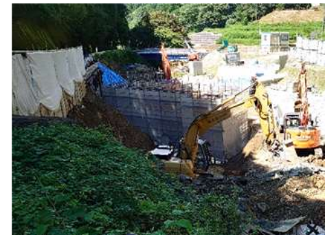
もものいち紅葉橋(施工中)
