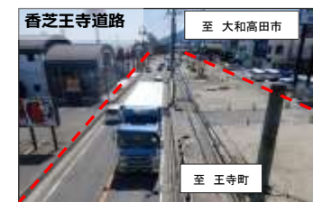
4車線拡幅工事を推進(香芝市上中)
