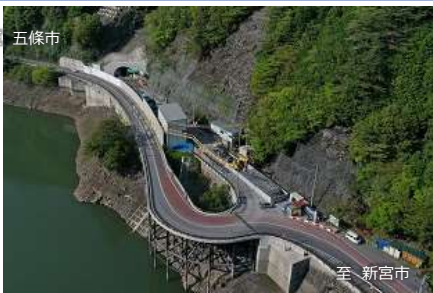
トンネル工事を推進(五條市 大塔町小代)
