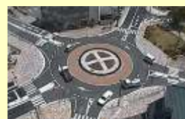
▲長野県飯田市東和町の環状交差点
